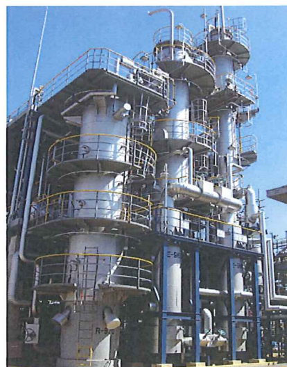
図 1.5 C5留分不純物除去設備
